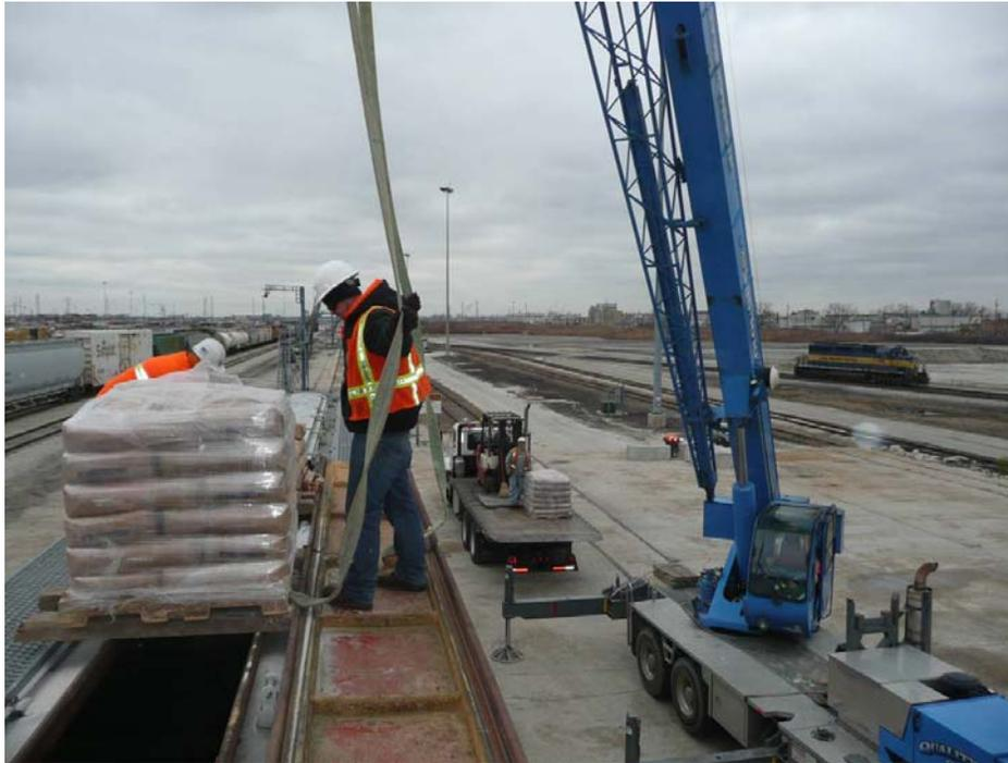
**PICTURE 4: HOPPER LOADED WITH CONCRETE BLOCKS FOR TIGHTNESS TEST**
